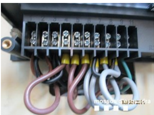
Un operari s'encarregava d'alterar el sistema que mesura el consum elèctric Foto: CME.
