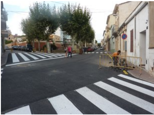
El carrer del Raval, ahir a la tarda, amb els darrers treballs després de les obres d'asfaltatge que s'hi han dut a terme. Foto: JOAN TRILLAS.
