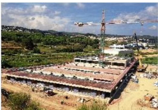
Imatges de les obres de la nova escola Sa Forcanera.
