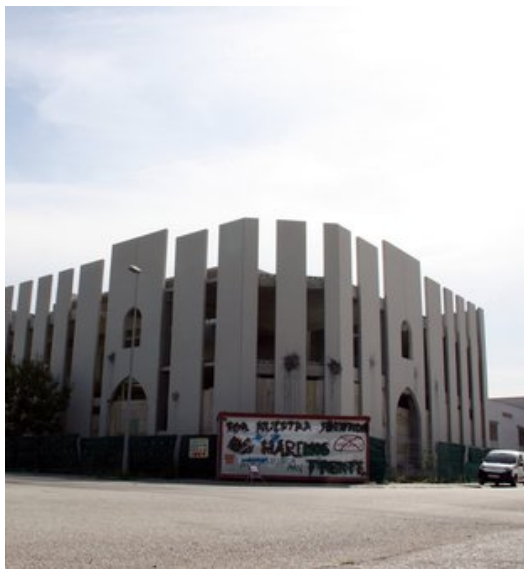
L'estructura exterior de la mesquita ja està construïda, però falta l'interior Foto: ACN.
