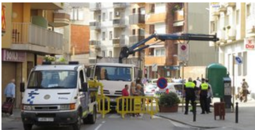
Una imatge d'ahir dels primers treballs d'arranjament de l'estructura de la riera de Blanes Foto: AJUNTAMENT DE BLANES.
