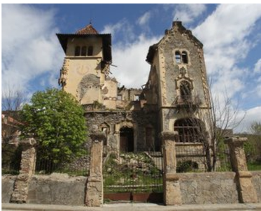
Can Roig, en una imatge d'arxiu en què s'aprecia el seu deteriorament. Foto: EL PUNT AVUI.
