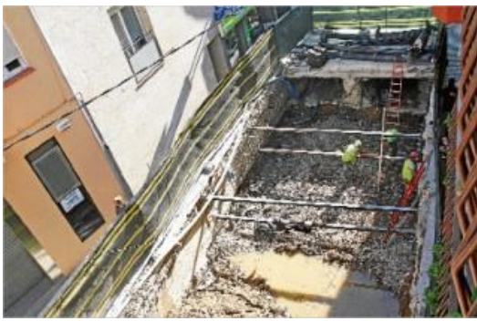
Una imatge d'ahir dels treballs de reparació del tram de riera a la rambla Joaquim Ruyra de Blanes.
