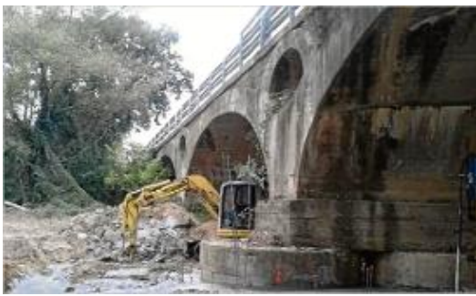
Una màquina treballant sota el pont de la GI-555 que s'ha de reparar.
