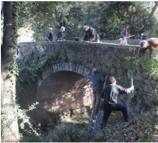
Els voluntaris quan treballaven en el condicionament del pont de la font del Salt Dalmau, de Camós, la setmana passada. Foto: MATEU BUTINYÀ.
