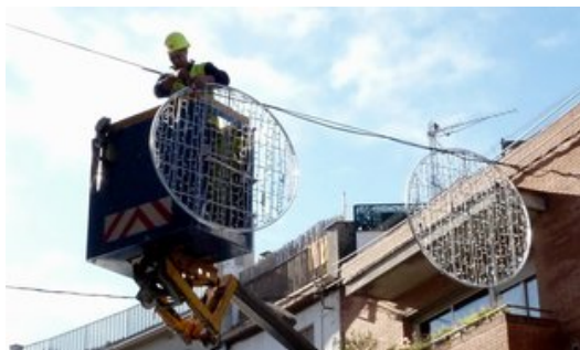
Un operari instal·lant llums al carrer Llibertat, ahir. Foto: R. E.
