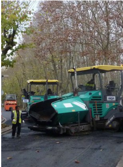
Màquines asfaltant el passeig de la Puda, última fase de la reforma d'aquest carrer, divendres al matí. Foto: R. E.
