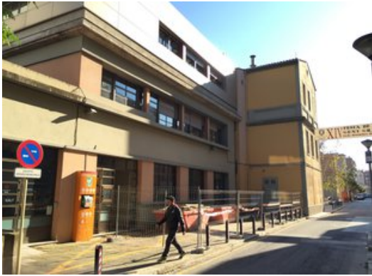
Fa una lateral de l'ajuntament on s'ha començat a treballar per a la reforma Foto: J.N.
