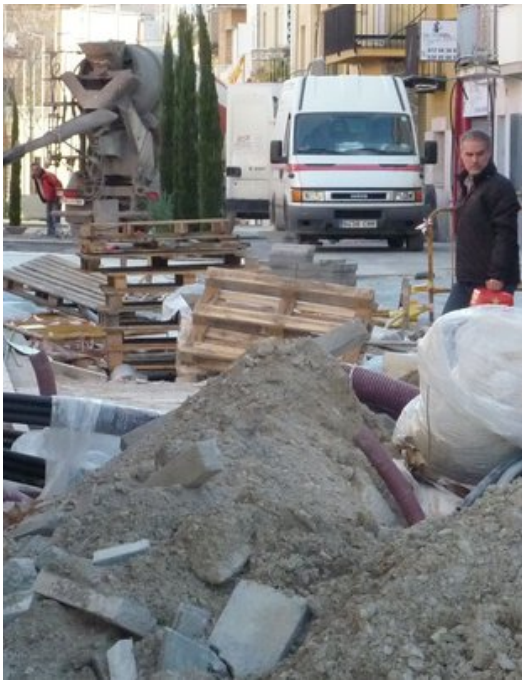
Estat de les obres al carrer de la Barca, en una imatge de la setmana passada. Foto: R. E.
