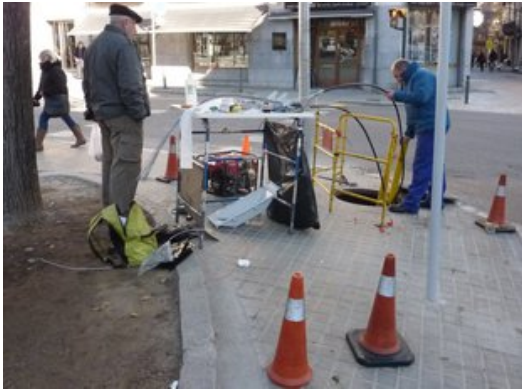
Uns operaris posant fibra òptica a la plaça del doctor Rovira, al centre de Banyoles, dijous d'aquesta setmana. Foto: R. E.
