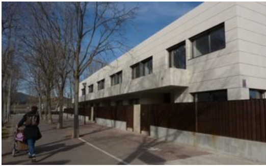
El conjunt residencial de la finca on hi havia hagut El Cisne, una part del qual s'haurà de tirar a terra. Foto: R. E.
