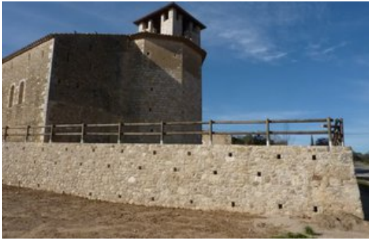
La part de l'absis de Sant Feliu i, en primer terme el mur de contenci . Foto: R. E.
