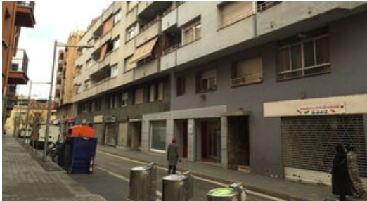
El carrer Doctor Ferran de Salt. Al centre de la imatge, als baixos, l'oficina d'habitatge Foto: J.N.
