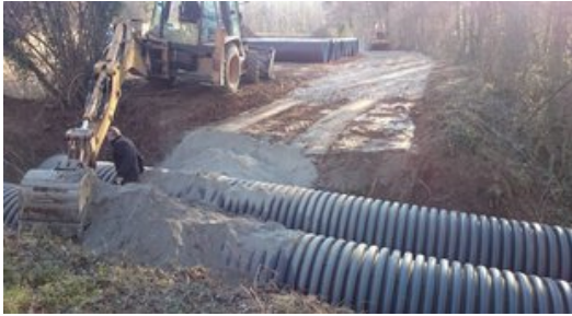
Un moment dels treballs que s'estan realitzant al camí que ressegueix el riu Turonell, al terme de Sant Joan les Fonts. Foto: J. C.
