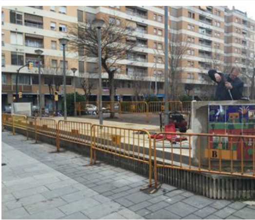
Un tècnic instal·lant aquesta setmana un marc metàl·lic entorn d'un dels murals de l'antic mur Foto: J.N.
