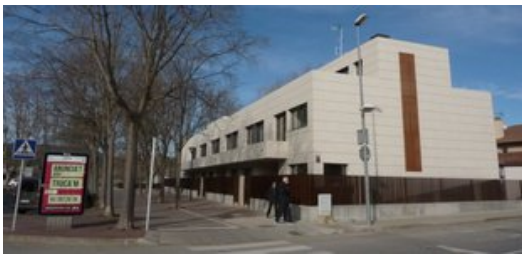
Les cases en filera de l'antic El Cisne . En primer terme, l'habitatge que probablement anirà a terra. Foto: R. E.
