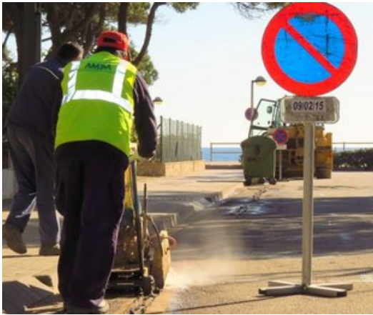
Una imatge de l'inici dels treballs de pavimentació al barri d'Els Pins de Blanes, ahir al matí. Foto: AJUNTAMENT DE BLANES.
