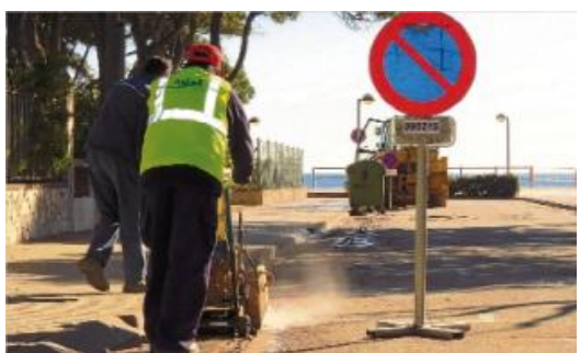
Una imatge de les primeres obres de pavimentació i reducció de barreres arquitectòniques, ahir a Blanes.
