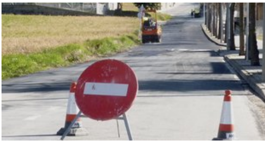
Treballs de reasfaltatge a la carretera de Vilavenut, aquesta setmana. Foto: R. E.
