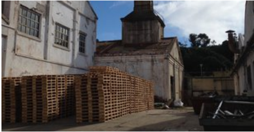
Una imatge de les instal·lacions de Nylstar. Foto: REDACCIÓ.
