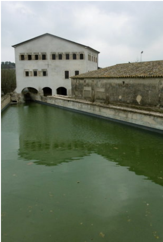
Un detall de la bassa amb l'edifici de la Farga d'Aram al fons. Foto: EL PUNT AVUI.
