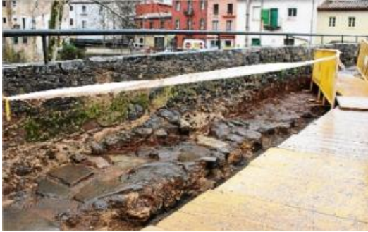
L'enllosat original del pont medieval de Sant Joan és de pedra local mitjana i gran.
