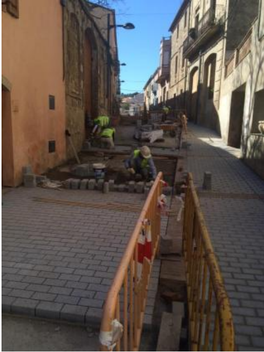
Obres als carrers d'Agullana
