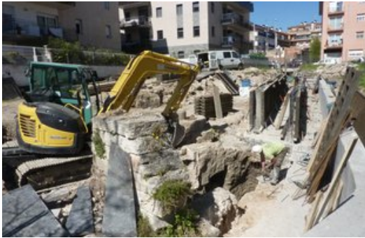
Les obres de construcció del nou passatge, a la finca de cal Nocaire, la setmana passada. Foto: R. E.
