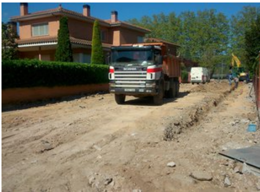
Les obres al carrer de la Barca , la setmana passada. Foto: R. E.
