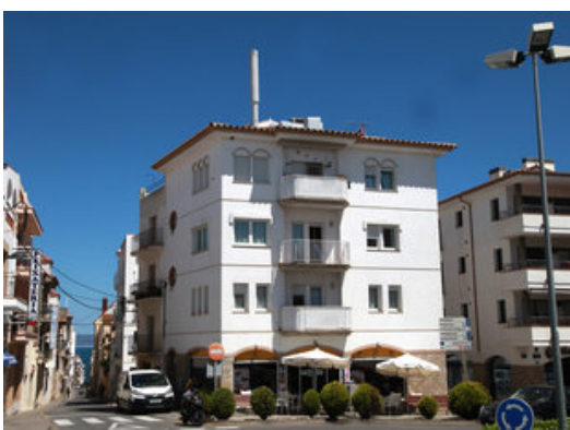
L'edifici d'e la plaça de les escoles, amb l'antena al terrat. Foto: JOAN SABATER.
