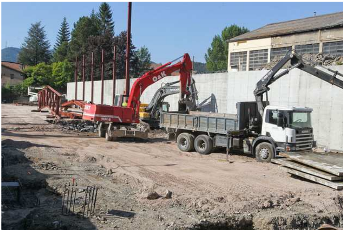
Estat de les obres de la nova nau de Comforsa, aquest dijous al matí JORDI PUIG
