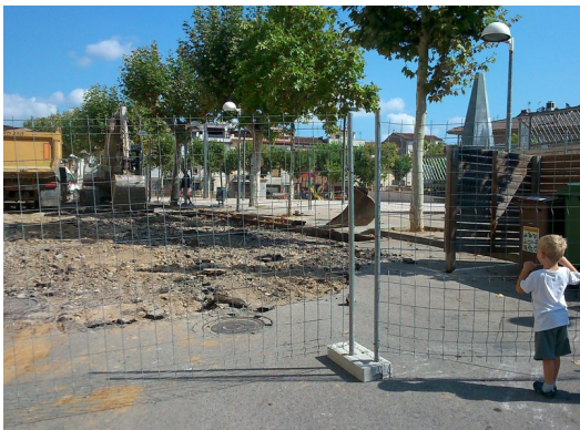
Una màquina arrancava l'asfalt de la calçada afectada per la reforma de la plaça, ahir, que va ser el primer dia de les obres. Foto: R. E.
