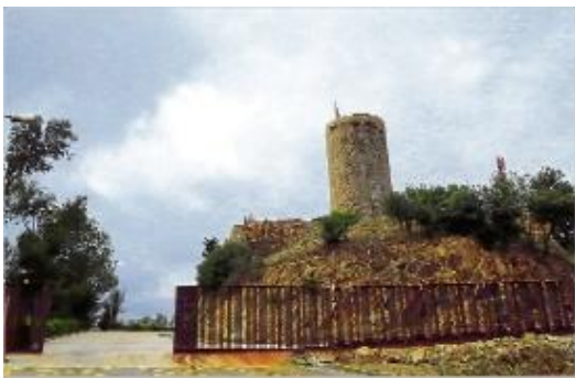
L'entrada al castell, amb el nou tancament.
