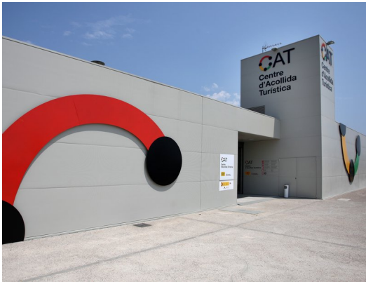
La façana de l'edifici del CAT de Vilajuïga en una imatge d'arxiu Foto: LLUÍS SERRAT.
