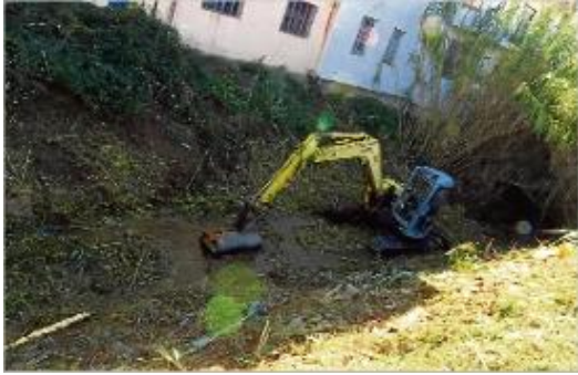
Els treballs de neteja de la riera en el tram on s'ha començat a actuar.
