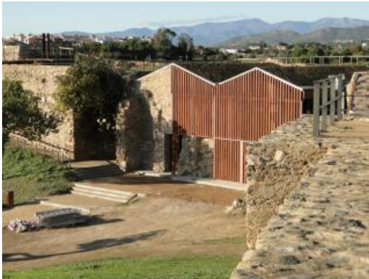
Les obres ja han finalitzat.
