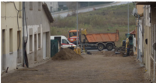
Vehicles de les obres treballant en un extrem del passatge Ventura. Foto: R. E.
