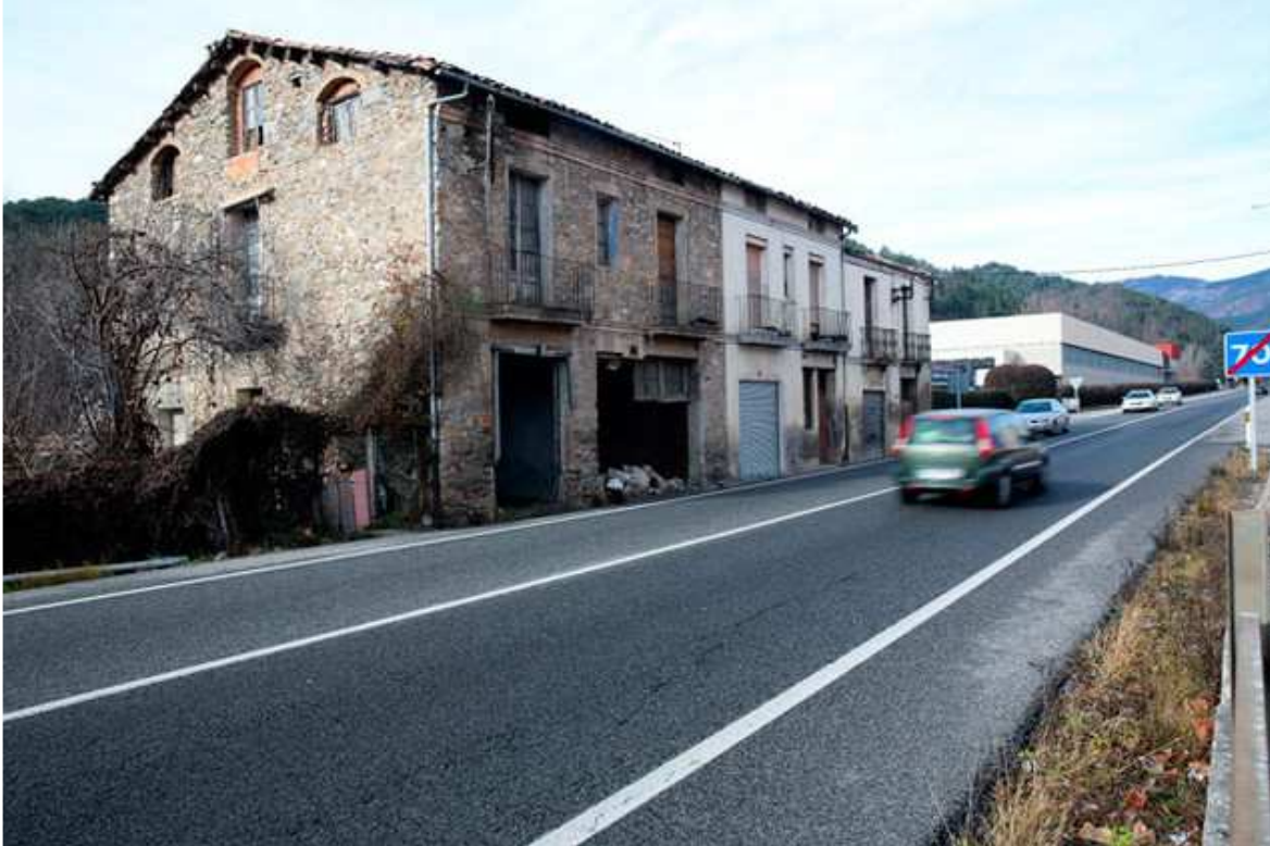
L'edifici de Can Lleida actualment presenta un estat d'abandó ALBERT LLIMÓS
