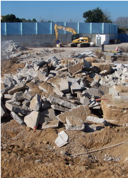
Els treballs de desmantellament, aquesta setmana, dins del perímetre de la subestació. Foto: EL PUNT AVUI.
