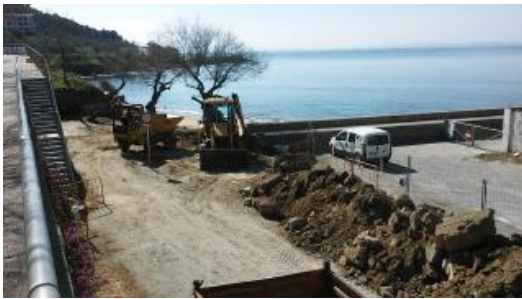
Les obres ja s'han iniciat.
