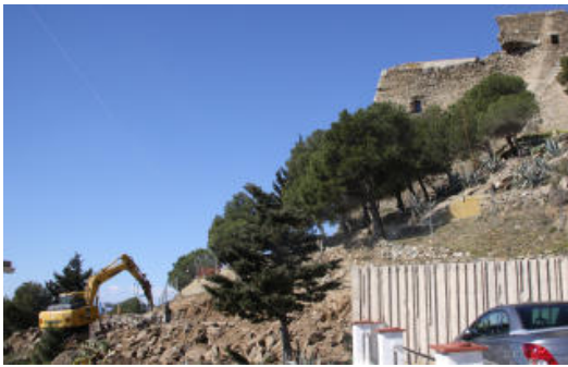
Les obres de construcció de l'aparcament
