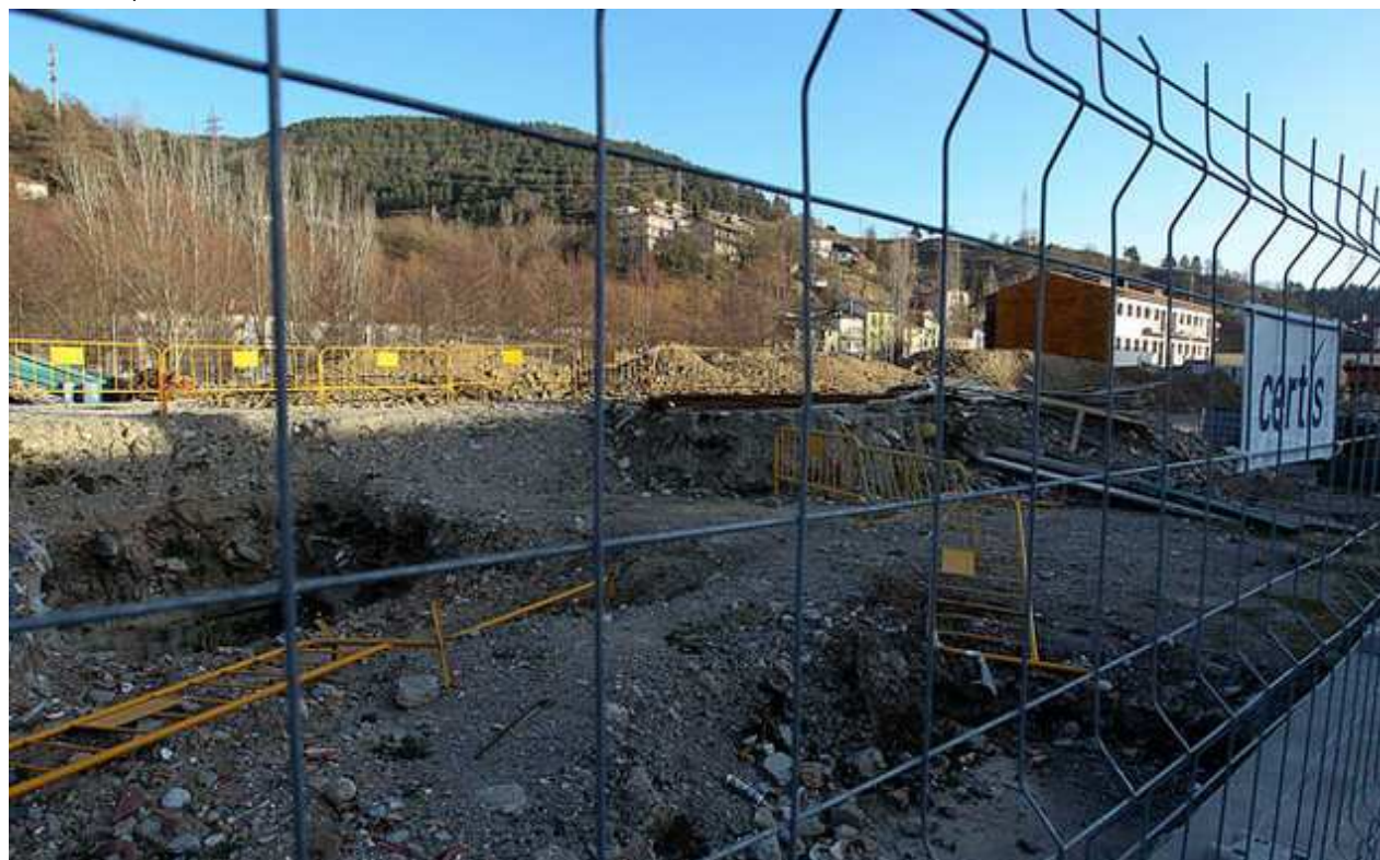
Actualment les obres de l'escola Pirineu de Campdevàrol estan aturades JORDI PUIG
