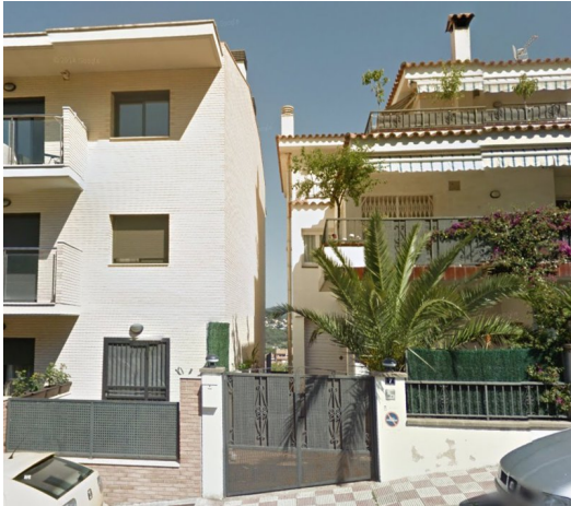
La casa de la veïna (a la dreta) afectada per la construcció de l'edifici. Foto: EL PUNT AVUI.
