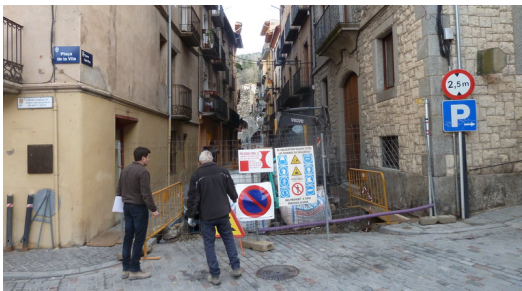
Els treballs del carrer sant Roc s'han iniciat pel sector de la plaça de la Vila. Foto: J.C.
