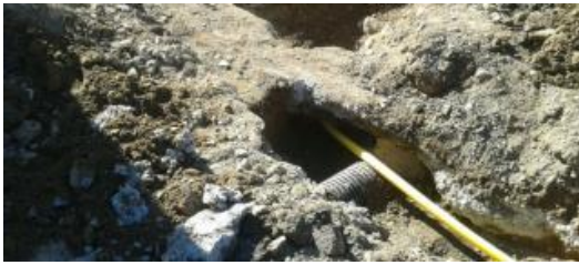
Obres per acabar als carrers
