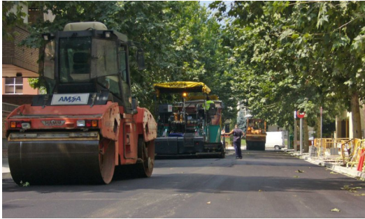
Màquines treballant en el reasfaltatge del passeig de la Indústria, en una imatge d'arxiu. Foto: R. E.
