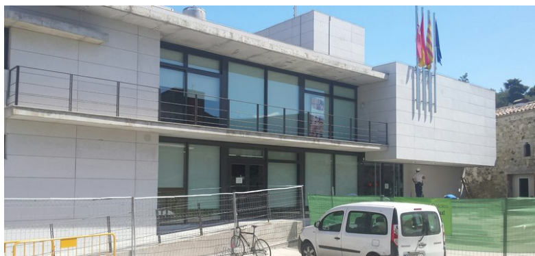
Una imatge recent de les obres de l'edifici de l'ajuntament de Caldes, que s'unirà amb Cal Ferrer de la Plaça (a la dreta) Foto: J.F.
