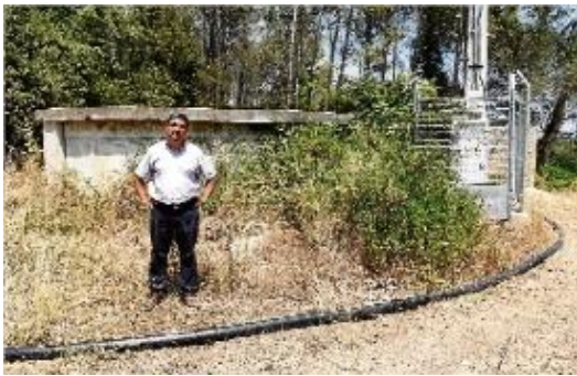
L'alcalde, Àlex Terés, davant la canonada construïda l'estiu passat.
