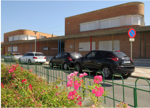
Imatge de la façana exterior de l'escola Quatre Vents de Blanes, on es construirà un ascensor Foto: AJ. DE BLANES.
