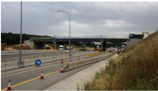
El pont que s'està construint a sobre l'N-II des de fa dies. Foto: QUIM PUIG.
